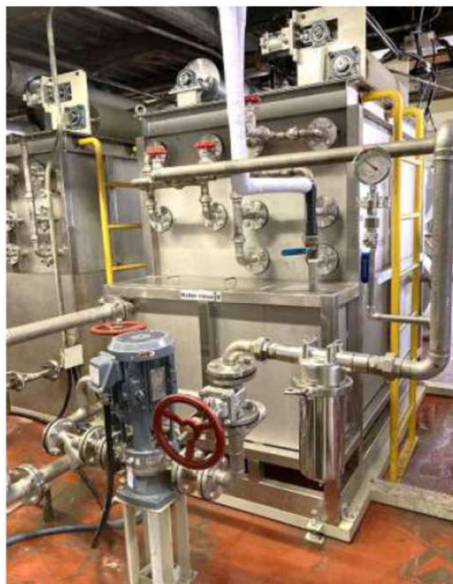
既設の蒸気配管、ドレン、給水、排水管に接続、乾燥炉の中のターンロールと入口ガイドロールも交換し完成。
