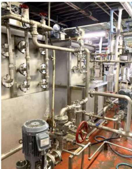
既設の蒸気配管、ドレン、給水、排水管に接続、乾燥炉の中のターンロールと入口ガイドロールも交換し完成。
