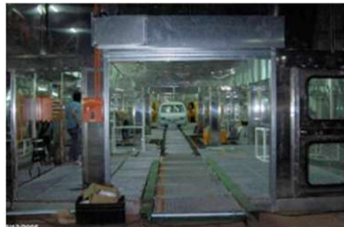
車体液体塗装室入口
