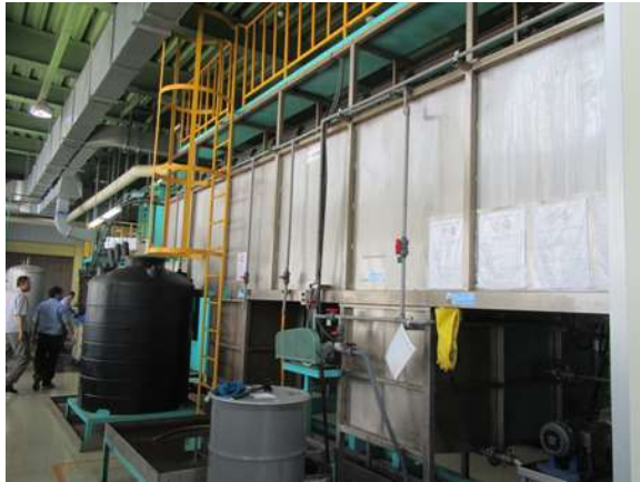
スプレーUF回収洗浄装置
