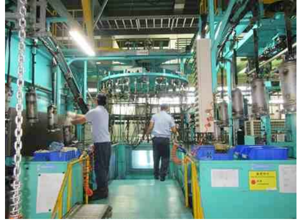
水中圧気漏れ試験装置
