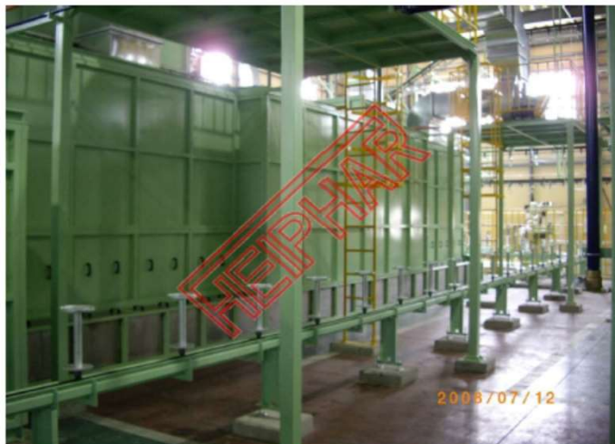
塗装ブース裏側及びフローコンベア(接液部SUS304) オールSUS304での製作も当然可能です。
