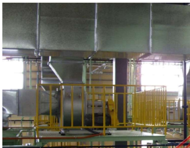
塗装乾燥炉の上部のダクト及び排気ファン
